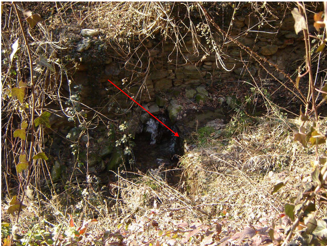
Foto 004 – Opera TREVSO004 . Ripresa da sponda sinistra del rio affl. sinistro del T. Chisone.
