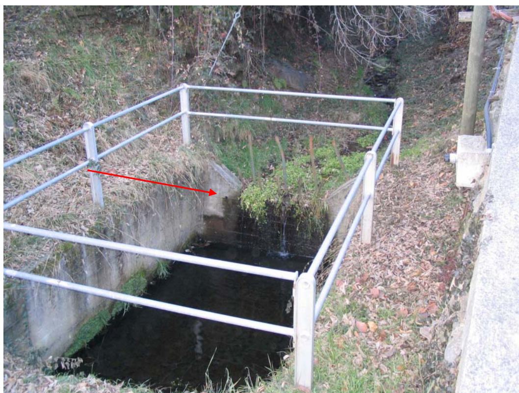
Foto 002 – Opera TREVSO002 . Ripresa da valle verso monte.
