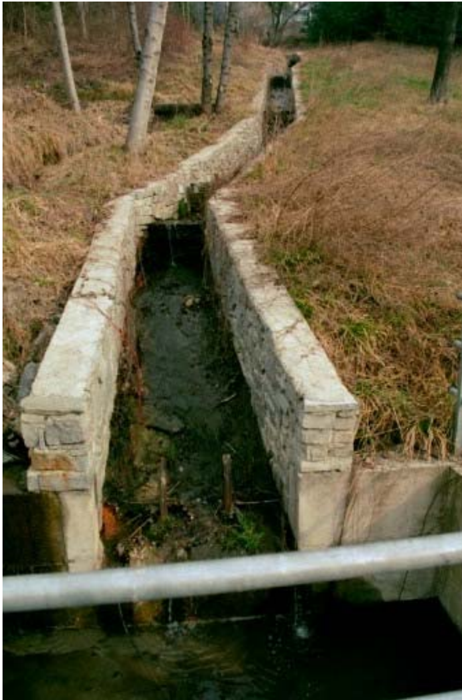
Foto 001 – Opera CANACA001 . Ripresa da valle, dall'attraversamento TREVAG003 .
