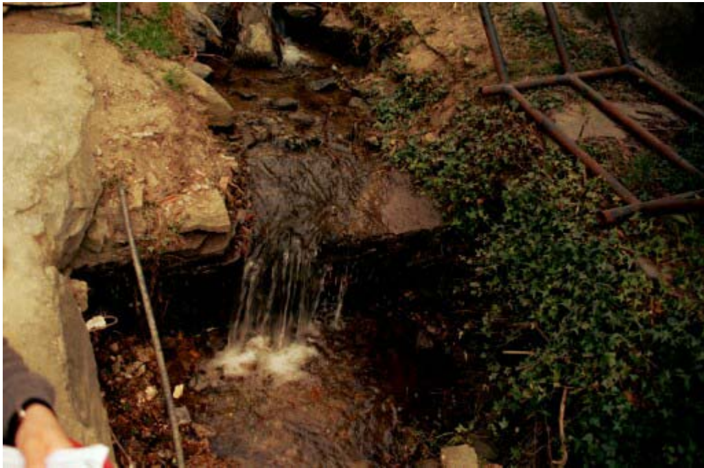
Foto 005 – Opera CANASO005 . Ripresa da valle verso monte.
