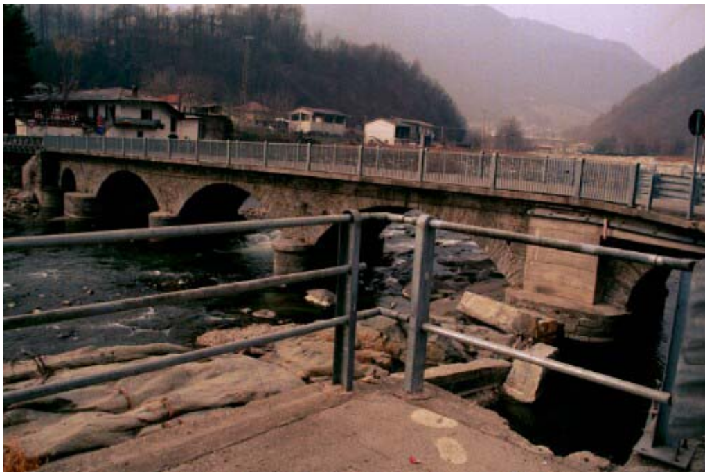
Foto 004 – Opera TREVPO004 . Ripresa da valle, sponda sinistra del T. Chisone.
