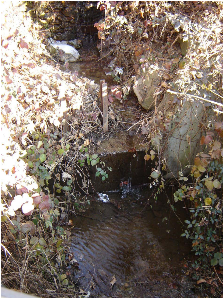
Foto 003 – Opera CANABR003 . Ripresa da valle verso monte.
