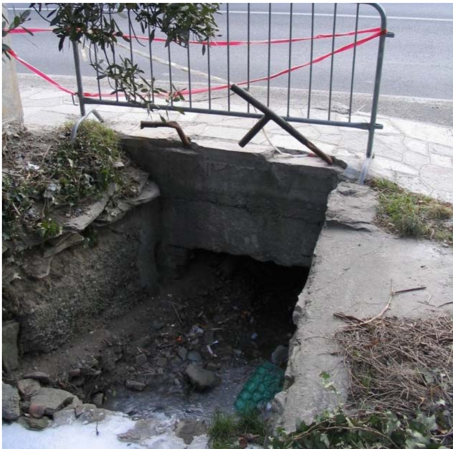
Foto 010 – Opera CANAAG010 . Ripresa da valle, sponda sinistra affl. sinistro T. Chisone.
