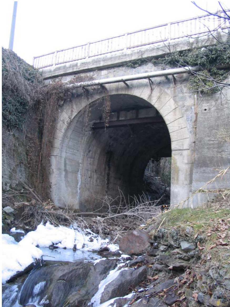
Foto 003 – Opera CANAPO003 . Ripresa da valle verso monte.
