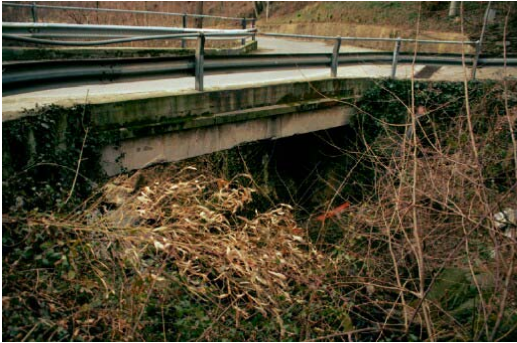
Foto 001 – Opera CANAPO001 . Ripresa da monte verso valle.
