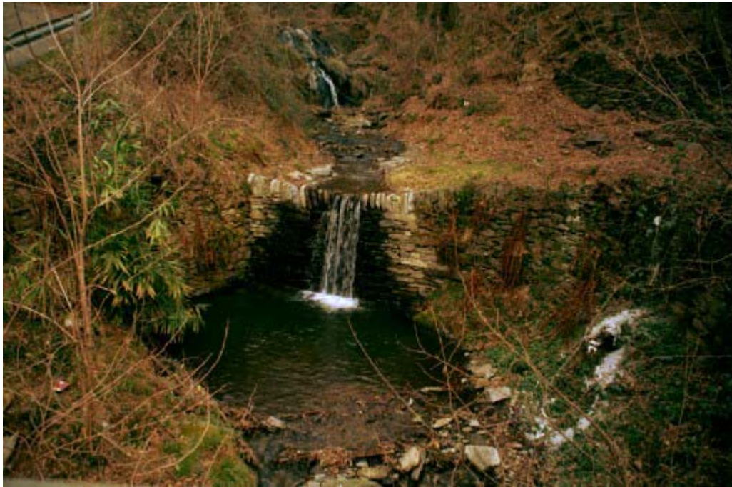
Foto 003 – Opera CANASO003 . Ripresa da valle verso monte.
