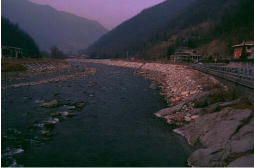
Foto 001 – Opera TREDSO001 . Ripresa da valle verso monte.
