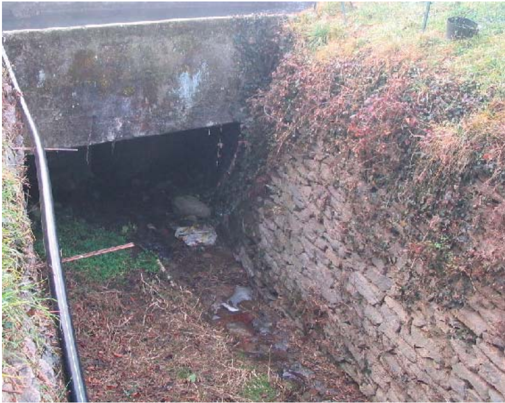
Foto 005 – Opera PENNDS005 . Ripresa da monte, dal muro di sponda BATTDS006 .
