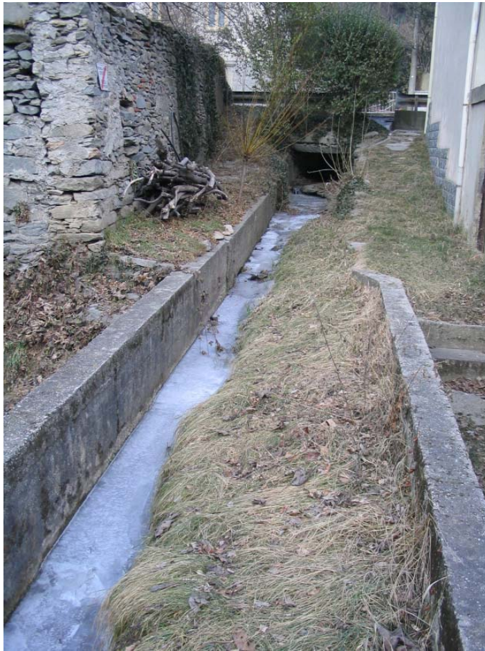
Foto 002 – Opera BATTCA002 . Ripresa da valle, in corrispondenza dell'opera.
