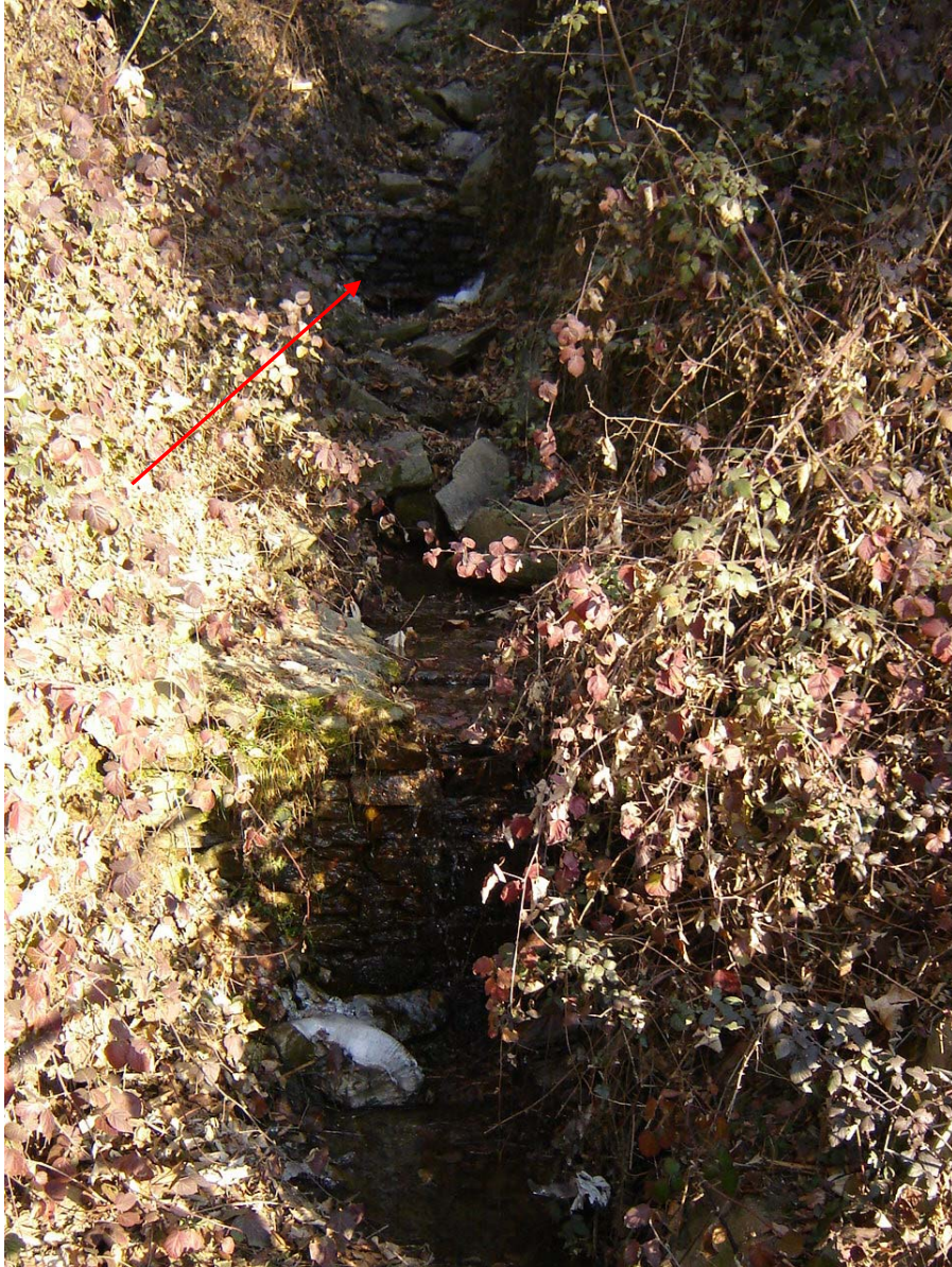
Foto 001 – Opera CANABR001 . Ripresa da valle verso monte.
