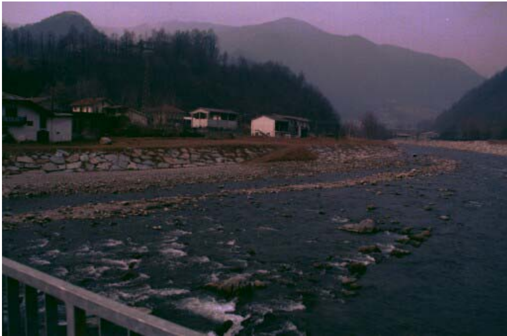
Foto 002 – Opera CANADS002 . Ripresa da valle verso monte.
