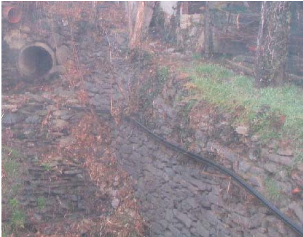
Foto 006 – Opera BATTDS006 . Ripresa da valle, dal canale artificiale (in alto a sinistra lo sbocco a valle dell'attraversamento TREVAG001 ).
