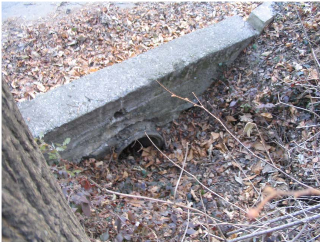
Foto 003 – Opera TREVAG003 . Ripresa da monte a valle.
